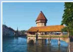
Kappelbrücke, Kanton Luzern
